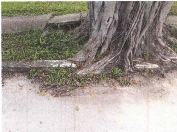
Foto 3. Vista de las raíces del árbol de Ficus donde se logra apreciar el levantamiento de la banqueta peatonal y la calle de la vía pública.
